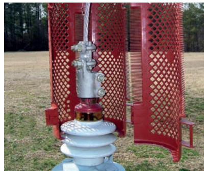
BCAC-IC mit geöffnetem Käfig (Gehäuse) während der Montage
