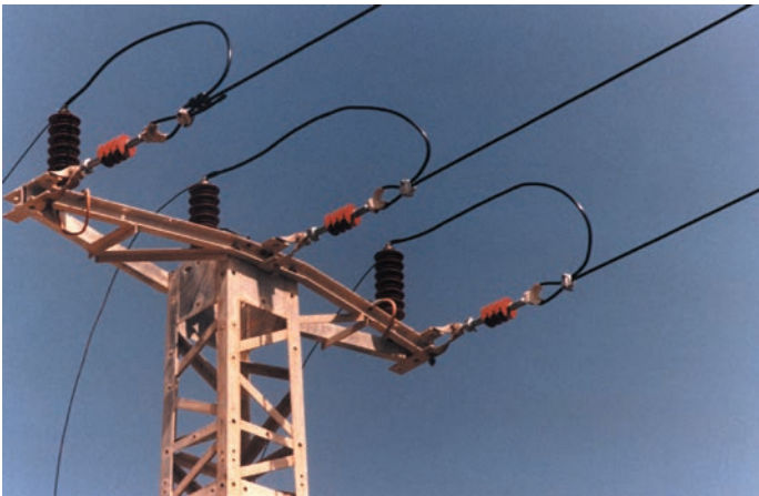
Zugisolator in Verbundbauweise
