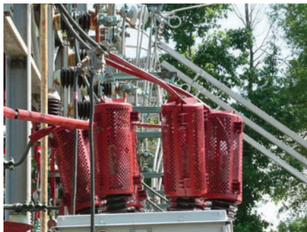
BCAC-IC mit geschlossenem Käfig (Gehäuse)
