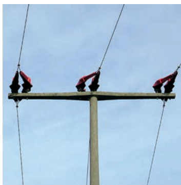
2 Hauben in paralleler Anordnung bei „doppelter Sicherheit“
