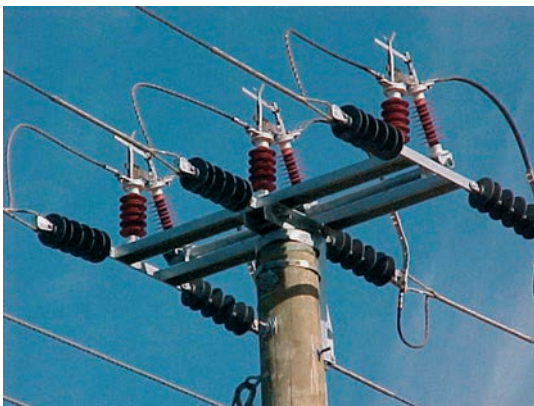
Leitungsstützisolator in Verbundbauweise
