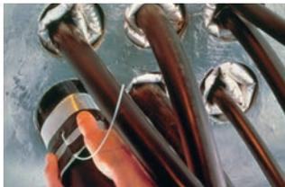
Nach Entfernen des Füllschlauchs verhindert ein automatisches Gel-Ventil-System einen Druckverlust. Die gesamte Installation nimmt selbst bei beengten Raumverhältnissen nur wenige Minuten in Anspruch.
