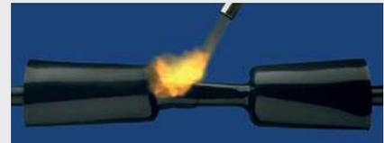
Zum Schluss wird die Außenmuffe positioniert und ebenfalls geschwumpft. Auch hier sorgt der Heißschmelzkleber für eine zuverlässige Abdichtung zwischen Außenmuffe und Kabelaußenmantel.
