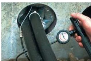
Mit der Füllvorrichtung wird die Abdichtmanschette RDSS mit einem Gasdruck von 3 bar gefüllt, so dass die Dichtmasse an die Innenseite des Rohres und an den Kabelmantel gepresst wird.
