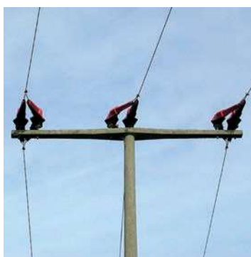
2 Hauben in paralleler Anordnung bei „doppelter Sicherheit“
