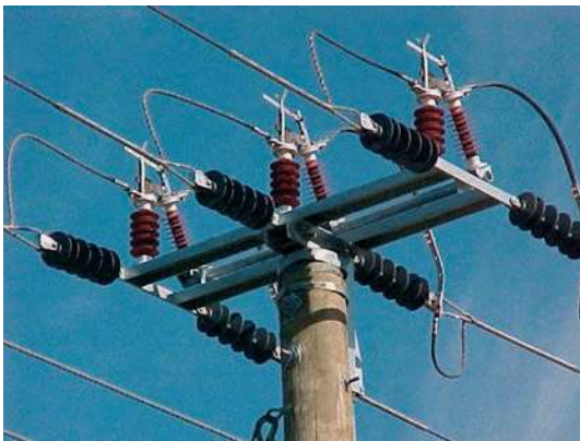
Leitungsstützisolator in Verbundbauweise
